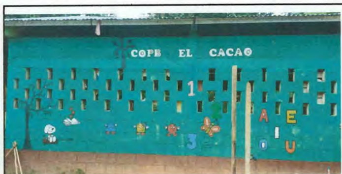
Foto 3: En esta parte se colocarán nuevas ventanas con estructura metálica, tipo balcon metida. Esto para que entre más oxígeno y que por dentro tenga más claridad.
