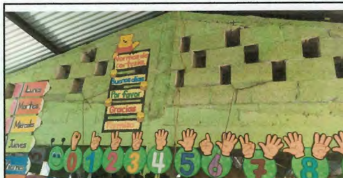
Foto 4: Se pondra repello todas las paredes. Dentro y fuera del aula.
