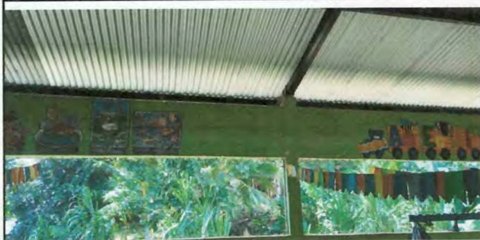
Foto 1: Se levantará la solera del aula de preprimaria, actualmente se encuentra muy baja.
